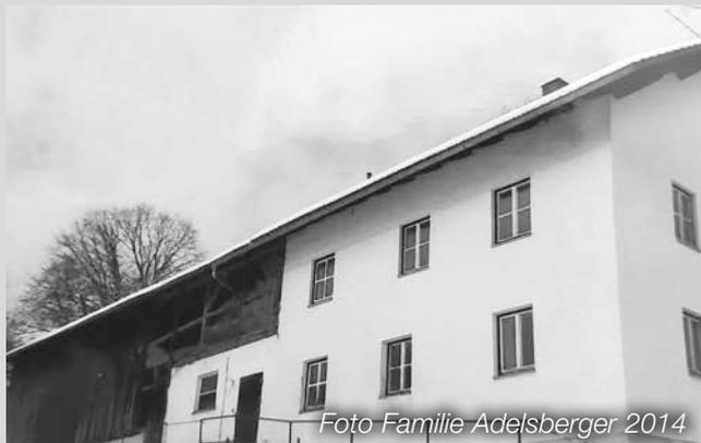
Bei diesem Gebäude handelt es sich um das ehemalige Heitzer-Haus in Euersdorf, Nummer 11, früher Nummer 25. Wir sehen vor uns ein einfaches, komplett gemauertes Gebäude mit ausgebautem erstem Stockwerk und angebautem Stall mit Scheune. Ein eingadiges Haus: alles unter einem Dach. Vor der Gred versteckt sich der Misthaufen unter dem Schnee. Das Gebäude dürfte in den 1930er Jahren errichtet worden sein, das genaue Jahr ist unbekannt.
